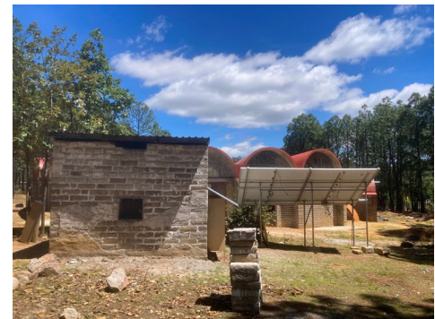
El horno solar para secar madera y los paneles solares. Foto: Diana Negrín
